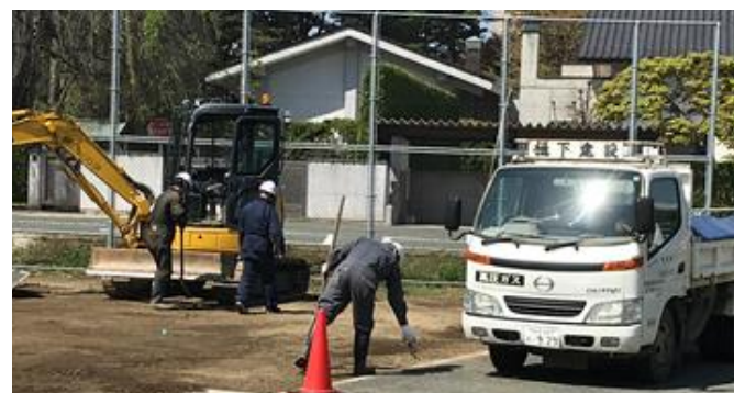
《樋下建設(株)による整地作業》
